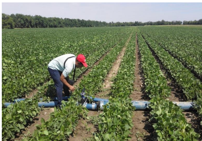
Рисунок 19 – Натягивание капельных лент и орошение системы капельного орошения
