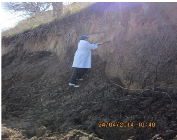
Рисунок 3 – Обрушение лицевой части северного склона обрыва
